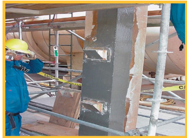
Concrete pour forms before removal
