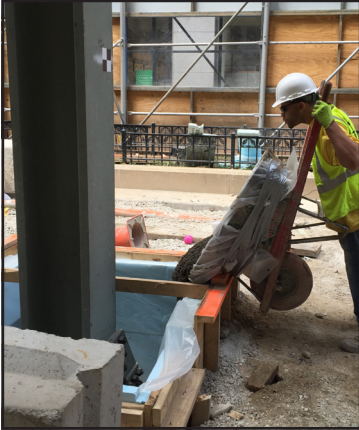
Pouring the DP Epoxy Grout
