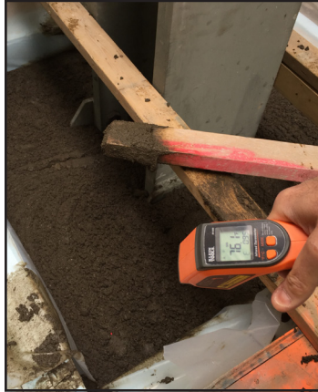
Monitoring Exotherm After Single 36" Pour
